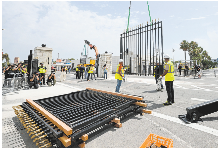
7月15日，在直布罗陀与西班牙拉利内阿—德拉康塞普西翁之间的陆路边境口岸，吊车将围栏吊起拆除。
