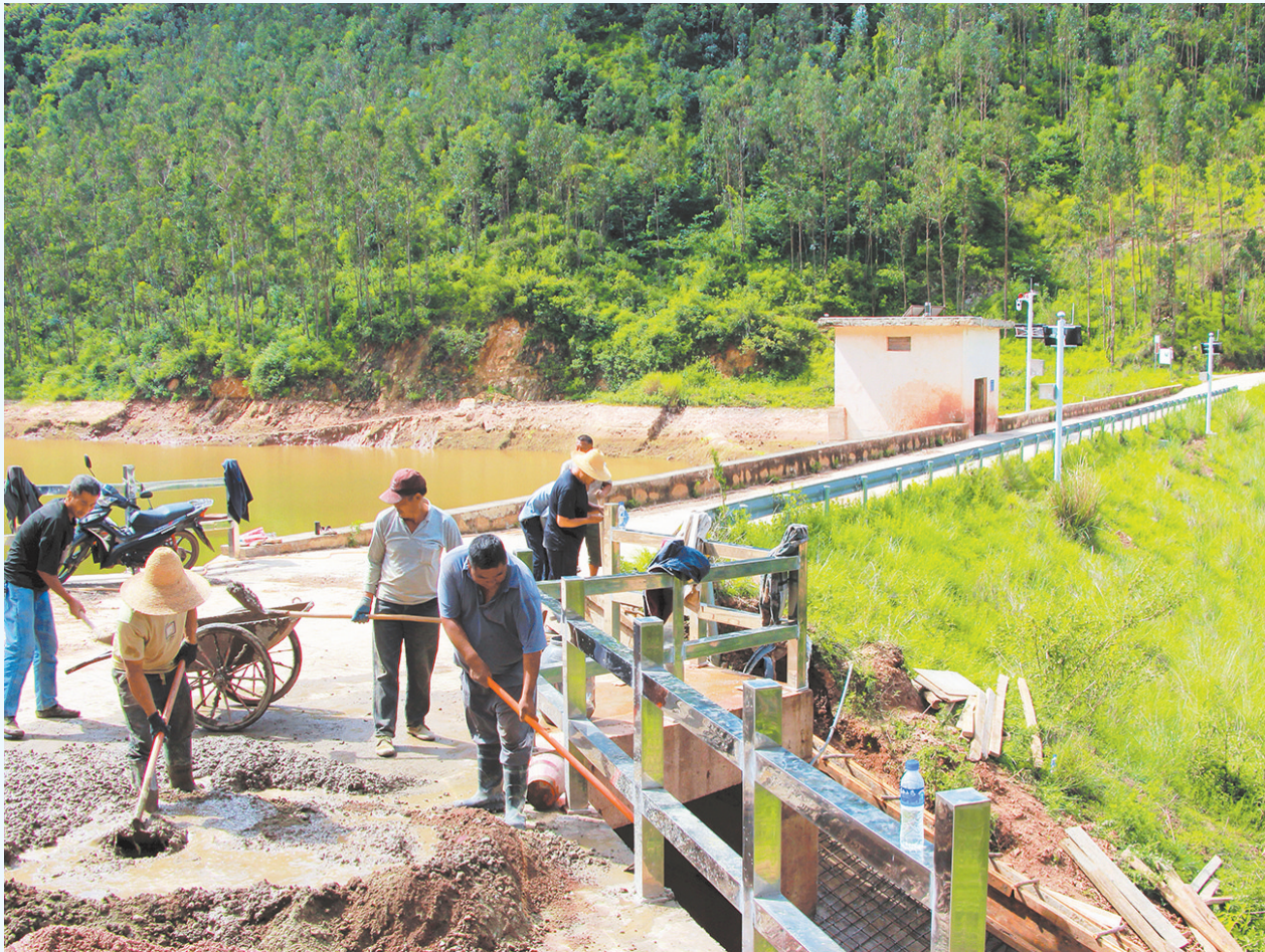
巍山县南诏镇自村村委会老荒桥水库大坝除险工程施工中。(摄于7月15日)连日来，南诏镇组织镇村组党员干部，对辖区内水库、库塘、蓄水池进行隐患排查，及时实施应急除险加固，筑牢汛期安全防线，守护辖区群众生命财产安全。
