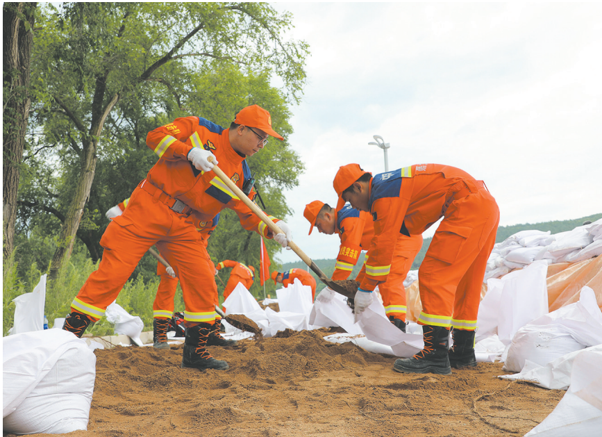
7月16日，黑龙江消防救援机动总队哈尔滨支队消防员在牡丹江市西安区温春镇江段的防洪堤坝上装填砂石袋，加固堤坝。近日，受上游来水增多等因素影响，位于黑龙江省牡丹江市境内的牡丹江西安区段水位持续上涨。多支力量赶赴防汛一线，加固防洪堤坝，筑牢防汛屏障。
