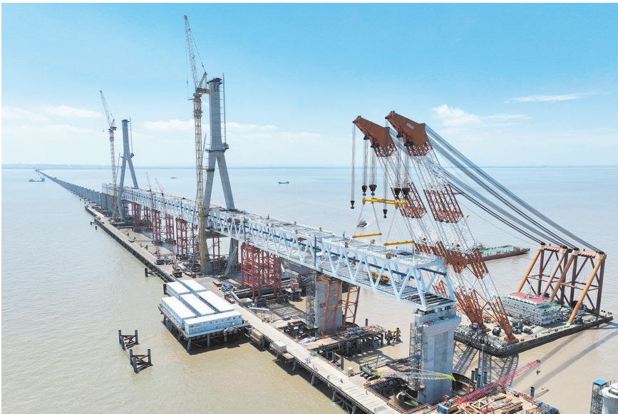
7月26日拍摄的杭州湾跨海铁路大桥南航道桥钢桁梁架设现场（无人机照片）。7月26日，由国铁上海建设公司建设管理、中交二航局承建的杭州湾跨海铁路大桥南航道桥钢桁梁全部架设到位，标志着这一工程建设取得阶段性进展。杭州湾跨海铁路大桥是新建南通至宁波高速铁路关键控制性工程，全长29.2公里，采用时速350公里双线无砟轨道设计，由北、中、南三座航道桥及海中引桥、浅滩区引桥共同组成。 【新华社记者 黄宗治 摄】
