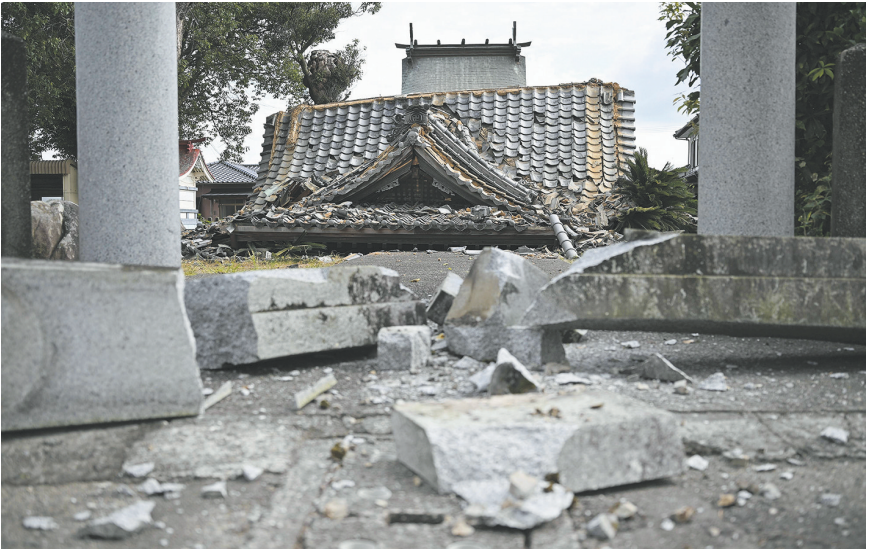
这是7月29日在日本熊本县拍摄的受损建筑。日本首相高市早苗7月29日在首相官邸说，截至当地时间上午8时30分，熊本县地震造成的死亡人数已达13人。据日本媒体报道，28日在熊本县发生的地震还造成多人受伤，多处房屋倒塌、人员被困，具体情况正在确认中。地震造成大范围停电和交通中断。截至29日早晨，熊本县内有超过9800人避难，约3.7万户停电。九州新干线29日从首班车起全线暂停运行。【新华社/共同社】
