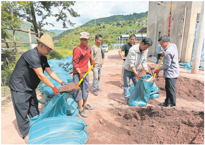
7月25日，漾濞县鸡街乡党员在因灾搬迁安置点带头装填沙袋、修筑防洪堤坝。受持续降雨影响，鸡街乡茆白村下鸡街小组滑坡地质灾害隐患点风险加剧，为确保坡脚群众的安全，鸡街乡迅速组建党员突击队下沉一线，亮身份、作表率，带动安置点群众主动参与，千群同心筑起一道道坚实的“防护墙”。 [通讯员 罗秋萍 摄]
