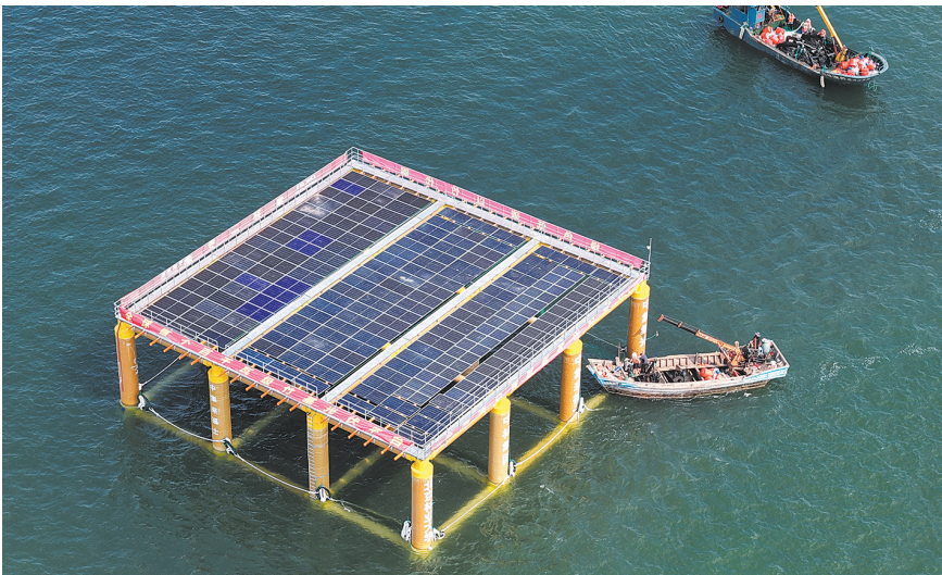
8月1日，在山东烟台海上光伏实证检测基地，工作人员在安装“集林二号”竹基海上光伏平台(无人机照片)。
