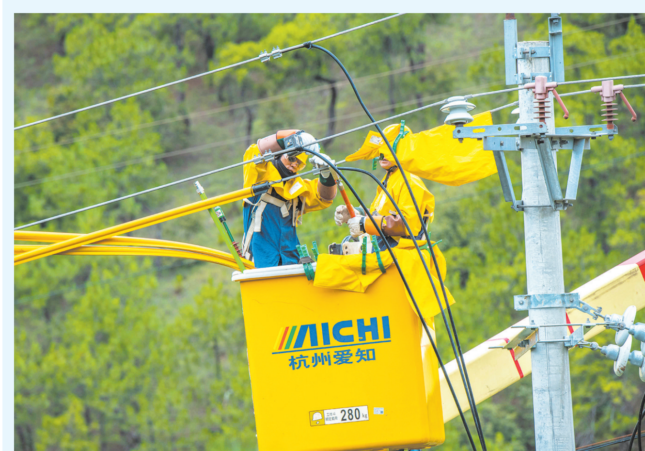
南方电网云南大理剑川供电局工作人员在沙溪镇进行作业。（摄于7月29日） 近期，南方电网云南大理剑川供电局在沙溪镇进行了2项作业，一项是在沙溪镇古镇核心区的生态停车场进行1600千伏安变压器新建工程建设，同时对6条400伏出线的电缆线路进行迁移；另外一项是在沙溪镇溪南村阁登村民小组将变压器容量由100千伏安增容为200千伏安。两项工作完成后，沙溪镇寺登村的供电可靠性得到提升。 [通讯员 王和星 摄]
