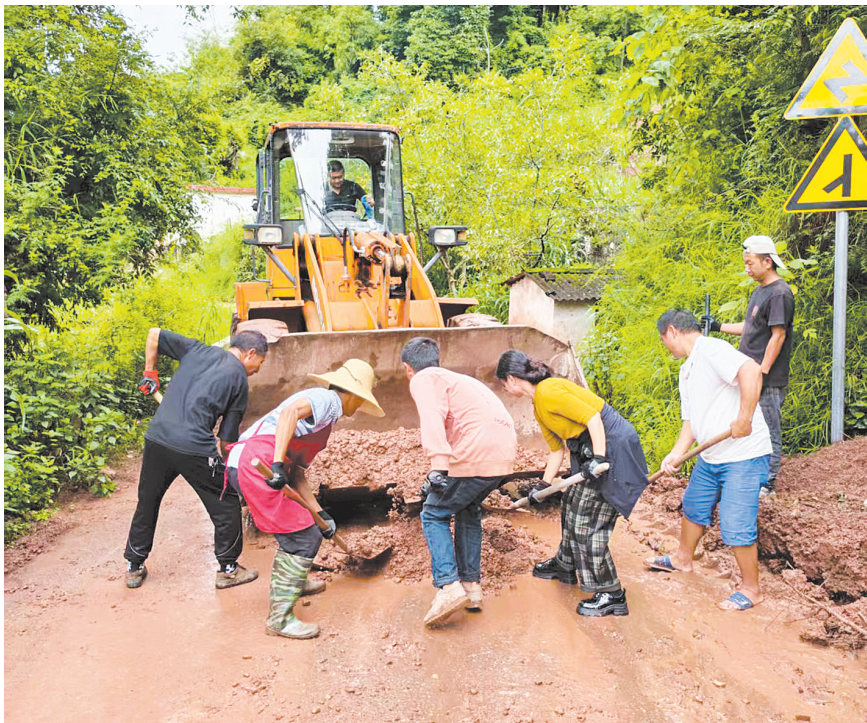
漾濞县苍山西镇密场村党员干部与群众一起清除道路淤泥。(摄于8月4日)
