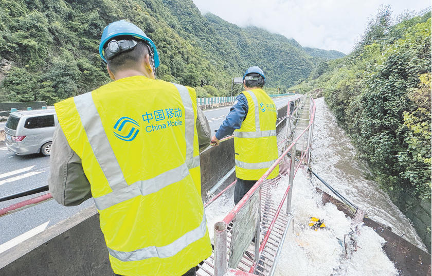
大理移动工作人员紧急抢修暴雨损毁光缆。(摄于8月3日) 当日上午9时许，大理市太邑乡杭瑞高速周边因持续暴雨引发山洪，高速沿线光缆桥架被洪水冲毁，造成干线中断，在做好安全评估、确保抢修人员人身安全前提下，大理移动迅速组织开展抢修工作。入汛以来，大理移动持续强化应急值守，备足防汛物资，严格落实7×24小时值班值守制度，全力保障辖区通信网络安全畅通。 [通讯员 杨顺姬 摄]
