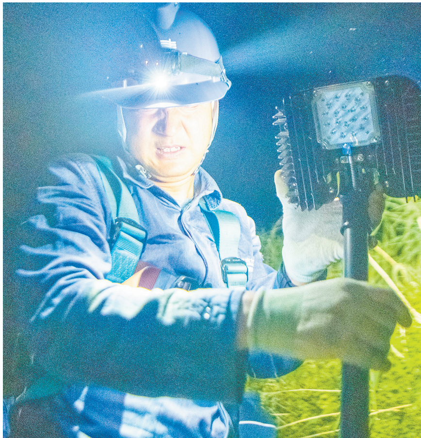
南方电网云南大理剑川供电局作业人员正在进行作业。(摄于7月25日)
