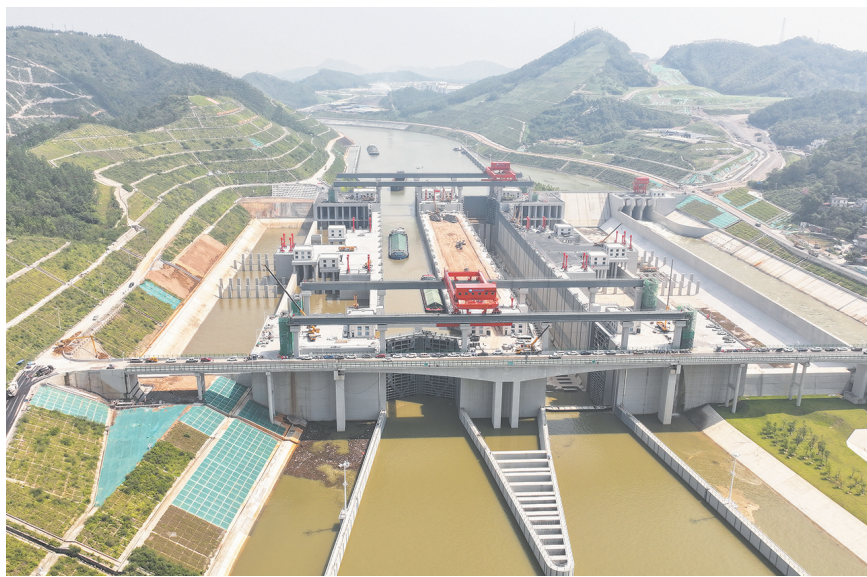
8月12日,试验船舶驶进平陆运河马道枢纽船闸(无人机照片)。 8月12日,平陆运河实船试验正式启动。据悉,此次试验将分阶段开展常规工况、不利工况通航验证和全线航标效能检测,全面检验运河航道、船闸、锚地、服务区及助航设施适配性,为平陆运河今年9月通航做好准备。
