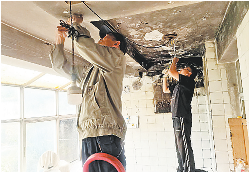
大理市下关街道南环社区工作人员和居民组长上门为辖区特殊困难户张奶奶 家检修电路,消除了用电安全隐患。(摄于8月13日)
