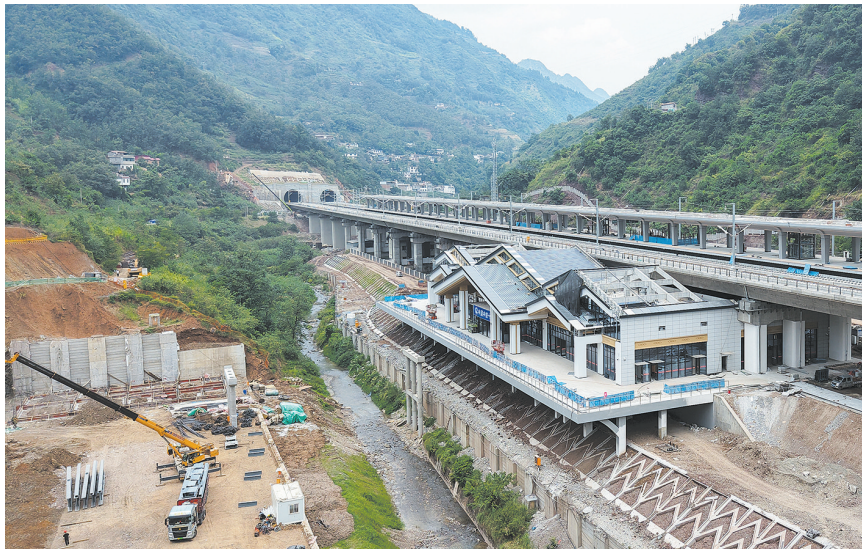
8月17日在云南省昭通市彝良县拍摄的正在建设的彝良北站(无人机照片)。
