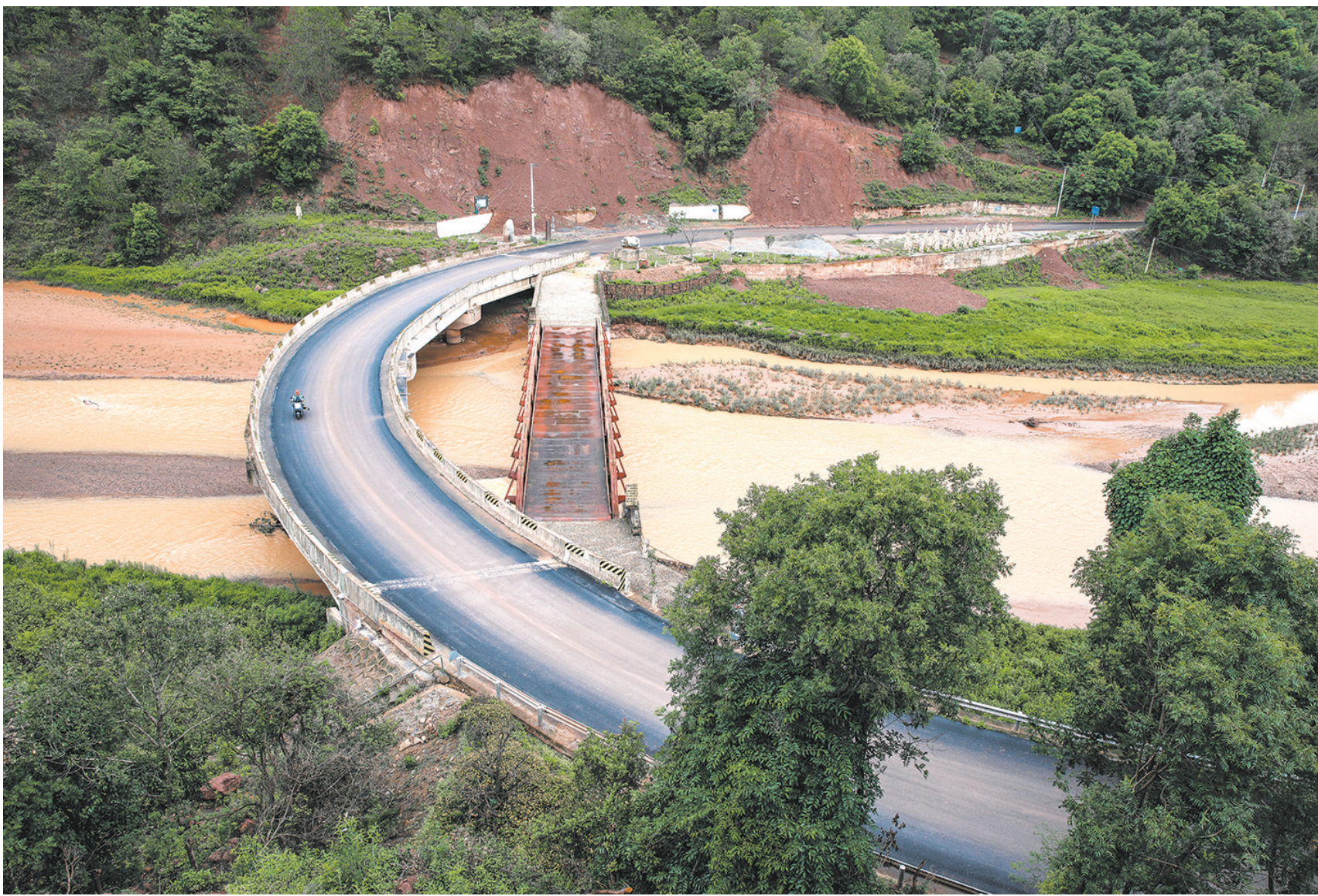
漾濞县太平乡胜备桥，1944年抗战时改建为单孔下承式钢桁架桥(右)，2006年，老桥旁修建起了一座水泥结构的桥。时光流逝，如今，老桥与新桥同框见证岁月变迁。(摄于2026年7月2日)
