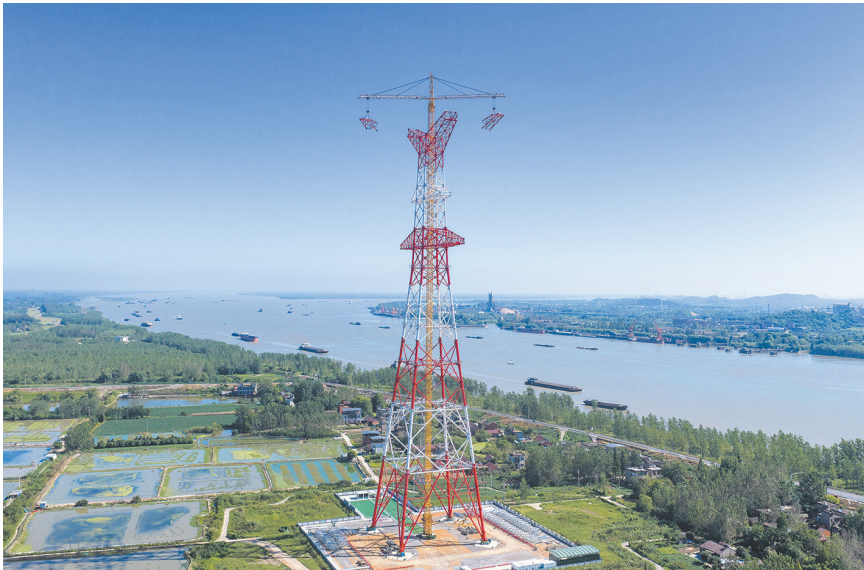
这是8月26日拍摄的甘浙特高压长江大跨越输电塔封顶作业现场(无人机照片)。8月26日，在安徽芜湖无为市高沟镇的长江边，经过建设者69天的施工，“西电东送”重点工程——甘肃—浙江±800千伏特高压直流输电工程长江大跨越196米高的北岸输电塔顺利封顶。
