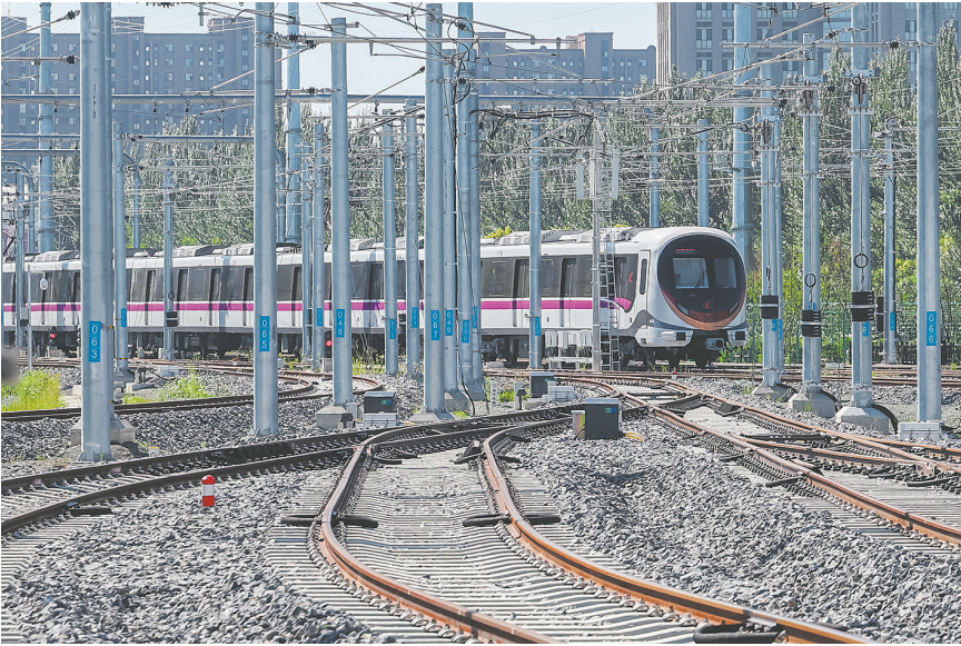
8月26日，地铁列车驶回长春地铁7号线靠山屯车辆段。8月26日，长春地铁7号线一期工程开通运营。至此，长春轨道交通线网运营总里程达到174公里，拥有车站150座。
