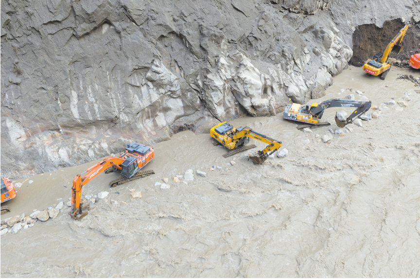
8月31日,大型机械在进行抢通作业(无人机照片)。 8月31日,中国安能集团组织大型机械在国道G216西藏日喀则市吉隆镇至吉隆口岸路段持续开展抢通作业。 【新华社记者 姜帆 摄】
