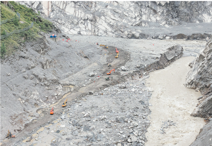
9月2日上午，大型机械在受灾核心区展开作业（无人机照片）。 9月2日上午10点，西藏吉隆口岸核心区区域救援通道已基本打通，救援人员、救援物资和部分装备已通过陆路通道进入核心区并开展深入救援工作。 【新华社记者 旦增尼玛曲珠 摄】
