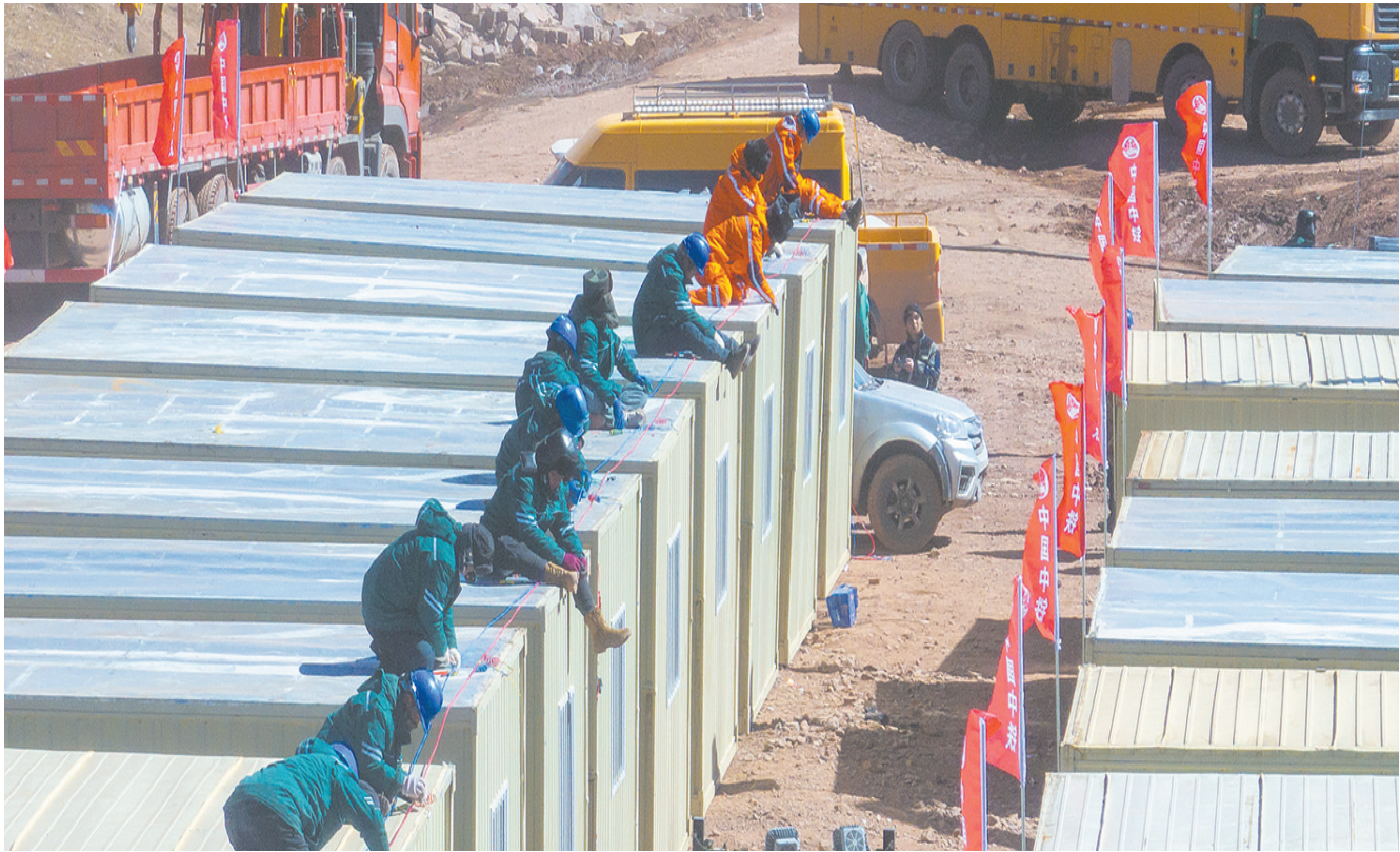
这是10月25日拍摄的巴青县玛如乡扎若改村安置点板房供电线路架设工作现场(无人机照片)。目前,西藏巴青震区安置板房供电线路正在架设中。据介绍,国家电网已调配2724顶帐篷接电物资、2400套板房接电物资,满足当前巴青震区现场接电需求。【新华社记者 丁增尼达 摄】
